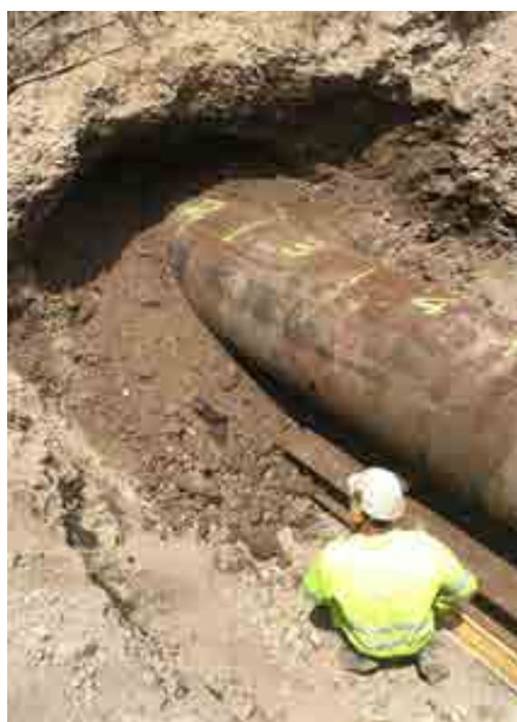
GSP / Sistemazione della rete fognaria di Lozzo di Cadore (BL)
