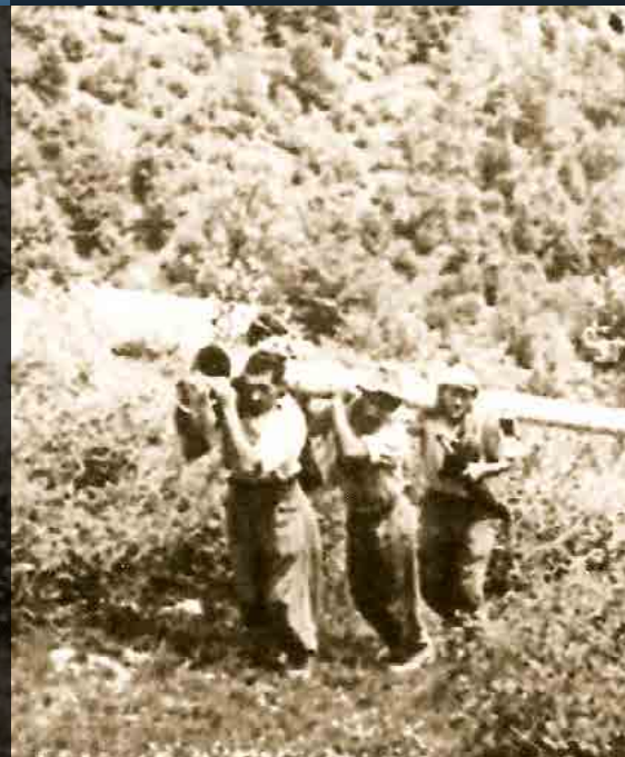
Venal, anni '50 - costruzione dell'acquedotto (foto archivio D. Torres)
