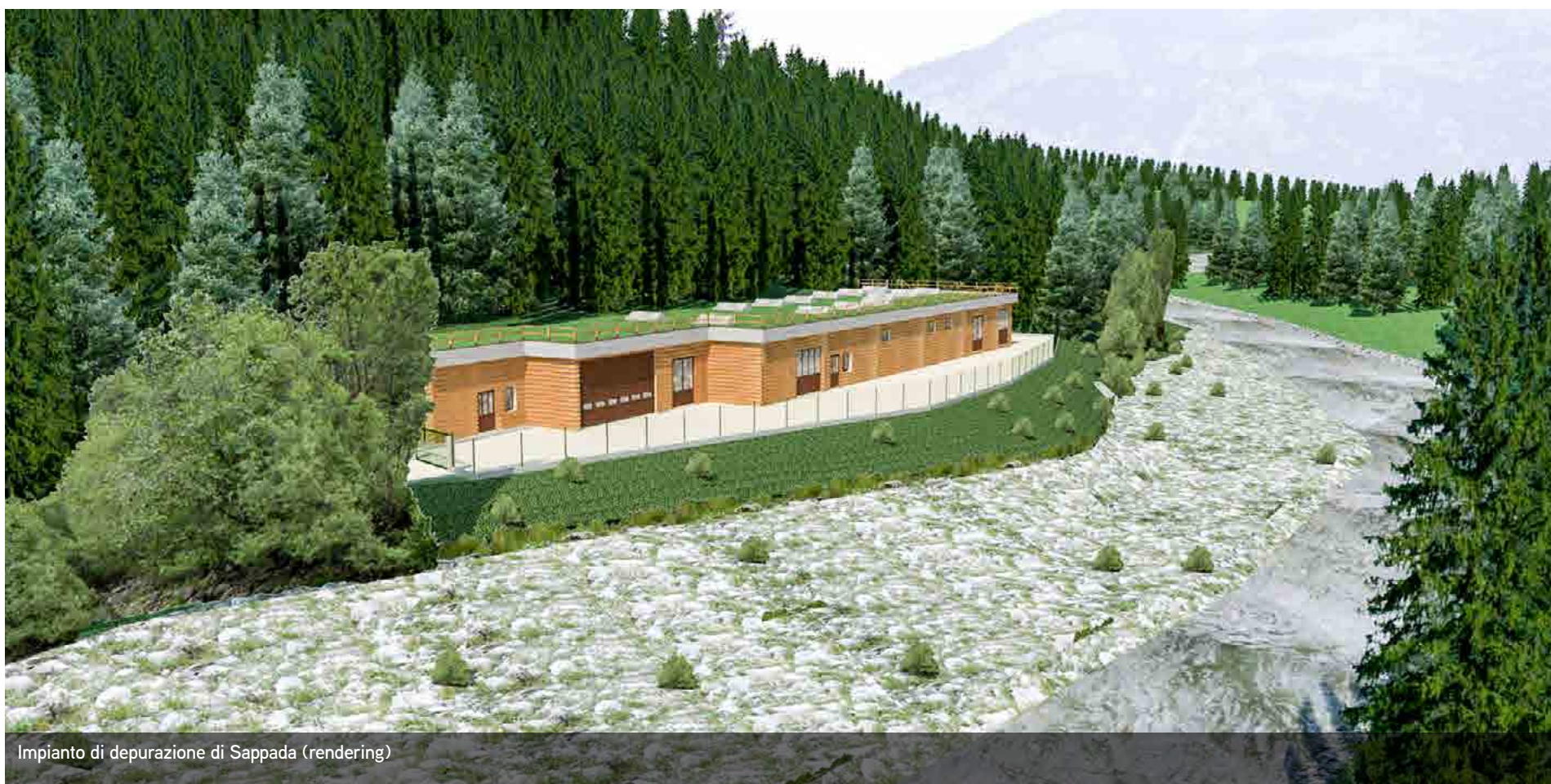
Impianto di depurazione di Castion (Belluno), loc. Pittanzella
