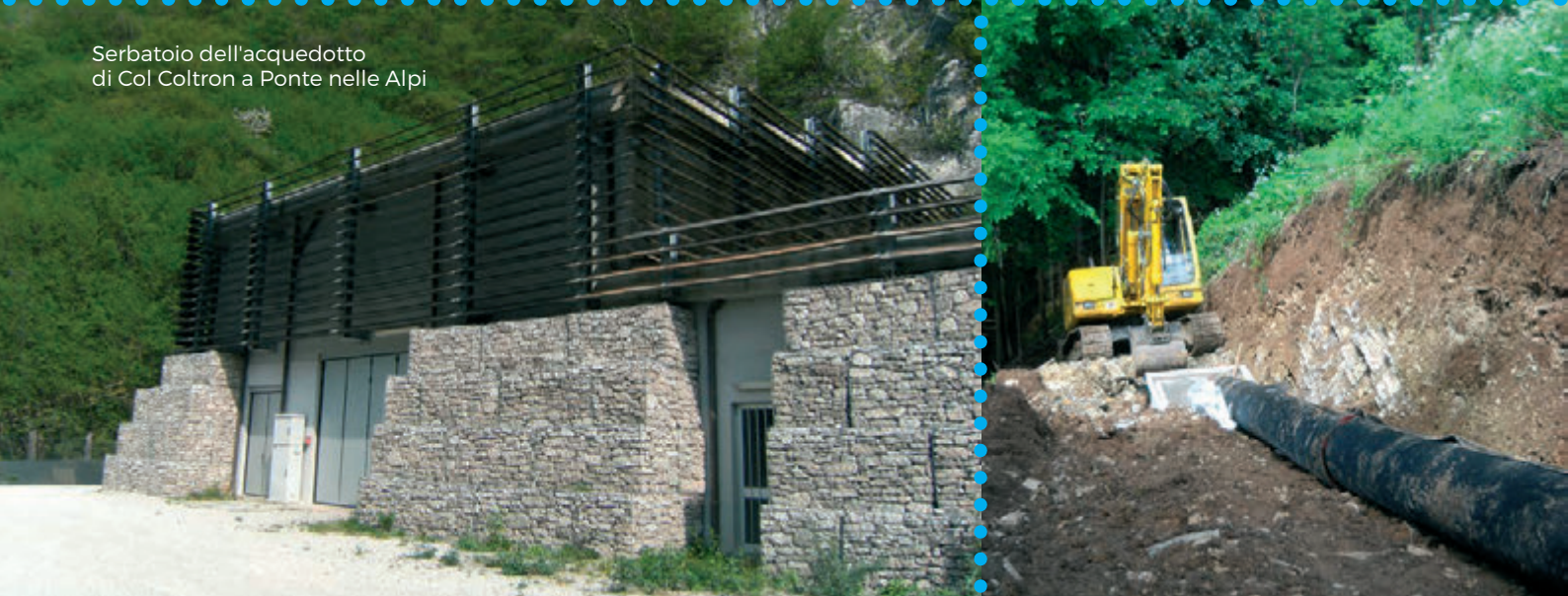
Nuovo depuratore di Sappada
